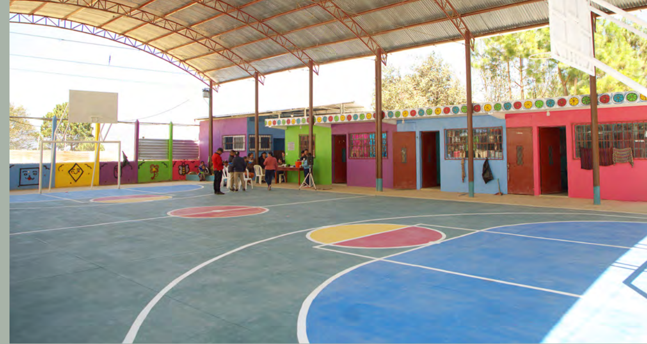
Mehr als 13 Jahre liegen zwischen diesen Bildern: Aus der Wellblechhütte (unten) wurde eine Schule, die bis heute gepflegt, genutzt und von der Gemeinschaft laufend weiterentwickelt wird.
