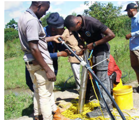
Der Durchbruch ist geschafft: Nach vielen erfolglosen Versuchen anderer Organisationen stießen die lokalen Expert•innen schon bei der ersten Probebohrung auf Wasser. Dafür musste jedoch 120 Meter tief gebohrt werden.
